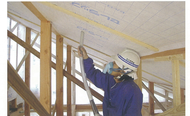
屋根吹き込み施工
