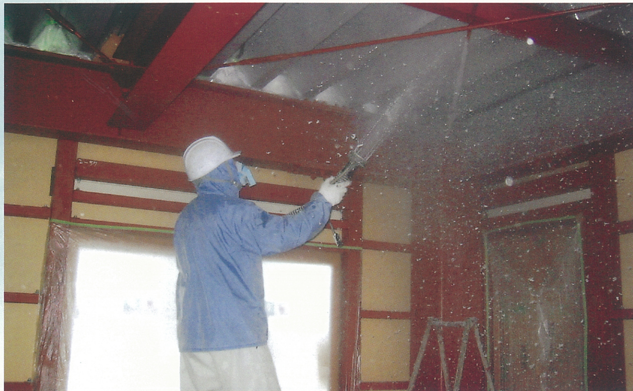
吹き付け施工
