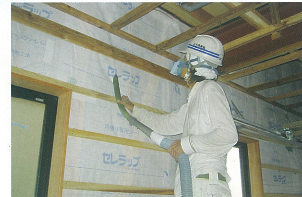
壁吹き込み施工
