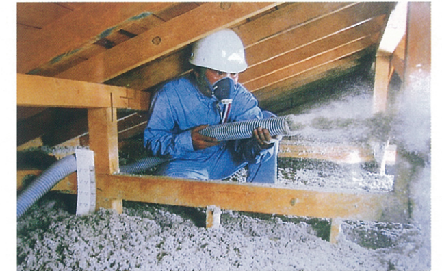
小屋裏吹き込み施工
